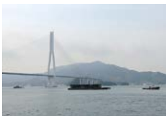
多々羅大橋
